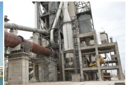
▲ Nhà máy xi măng
