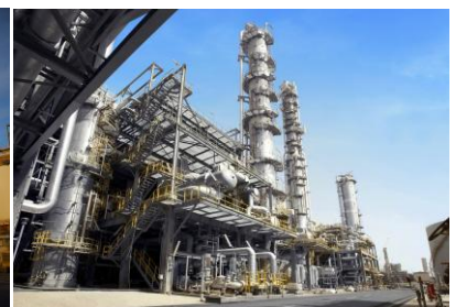
▲ Nhà máy lọc hóa dầu
