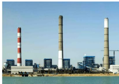
▲ Nhà máy nhiệt điện
