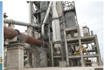
▲ Nhà máy xi măng
