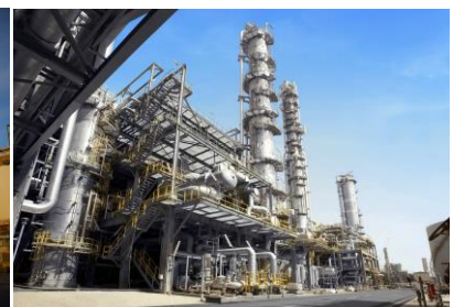
▲ Nhà máy lọc hóa dầu
