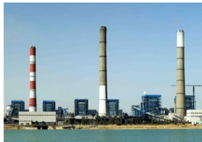
▲ Nhà máy nhiệt điện
